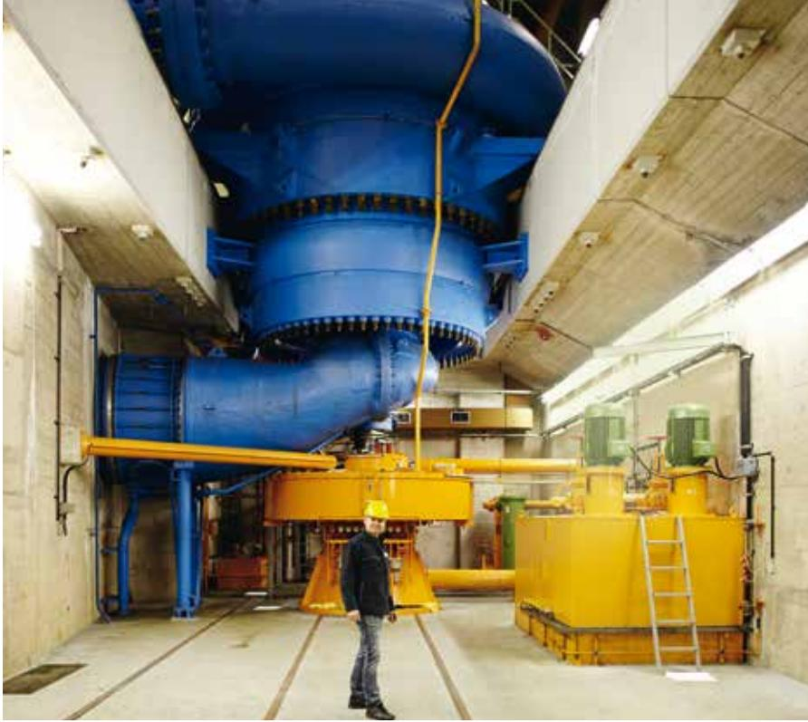
**Geballte Kraft.** Alois Hutter zeigt eine der 4 Turbinen in der Maschinenhalle des Pumpspeicher-Kraftwerks Malta. Sie wird derzeit gewartet.
