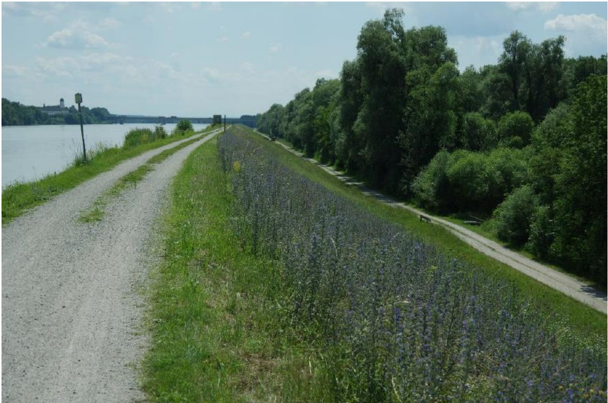
Oberes Drittel der landseitigen Böschungen
