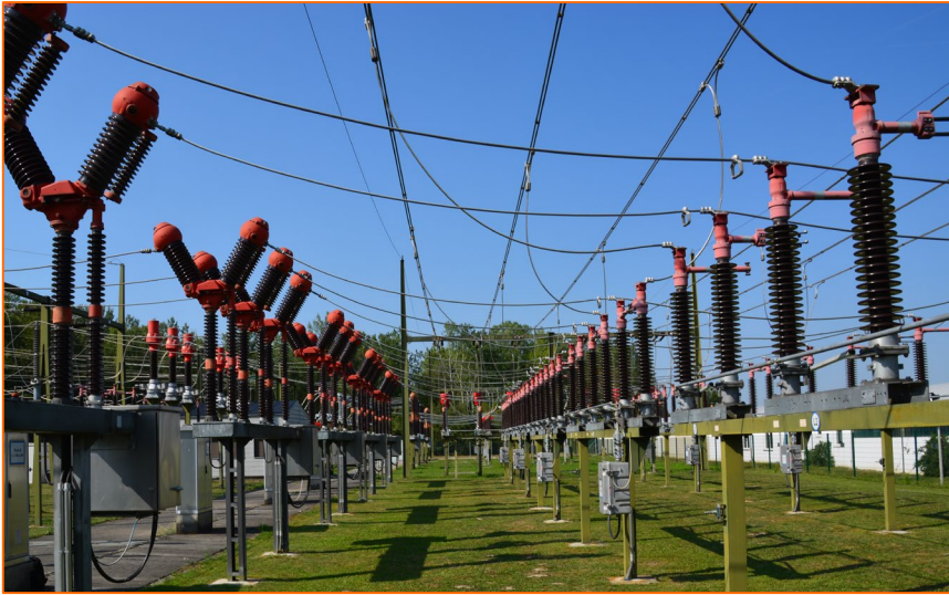
Bild: Visuelle Inspektion zur Erkennung möglicher Schadstellen
