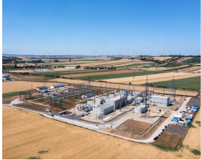
Im Zuge des Projekts wurde auch das Umspannwerk in Neusiedl an der Zaya neu errichtet.
