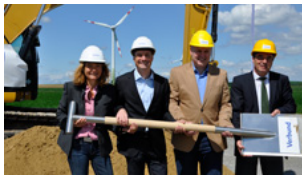
Spatenstich Windpark Bruck Göttlesbrunn
