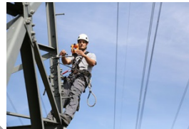
APG: Fertigstellung 380-kV-Leitung Dürrrohr-Sarasdorf
