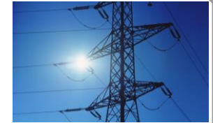
UVP 380 kV-Salzburgleitung: 1. Instanz ✓
