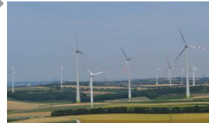
Inbetriebnahme Windpark Bruck-Göttlesbrunn
