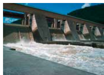
Hochwasserabfuhr über die Wehre beim Kraftwerk Aschach
