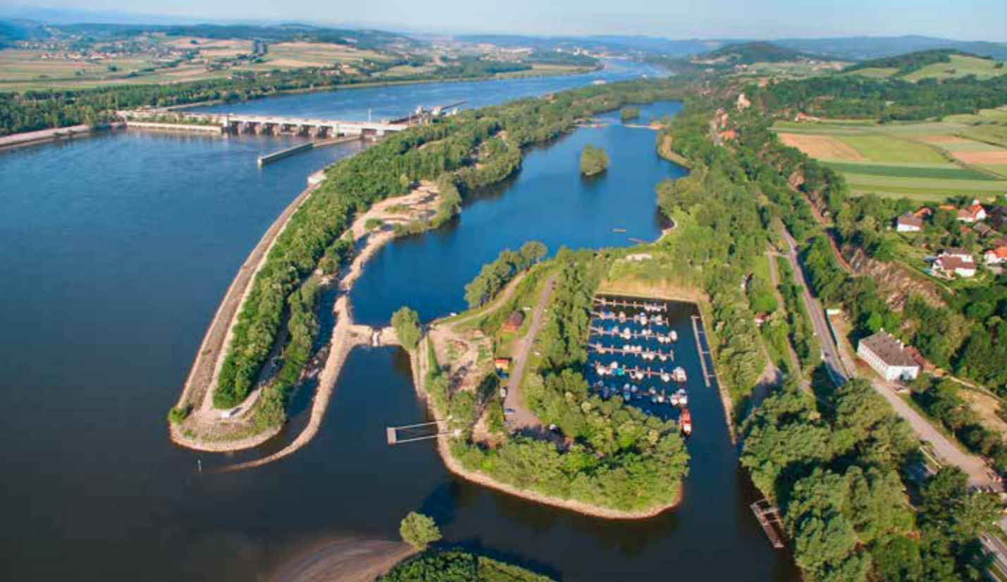
Fischwanderhilfe beim Kraftwerk Melk – der Einstieg liegt links unten direkt an der Spitze der Landzunge
