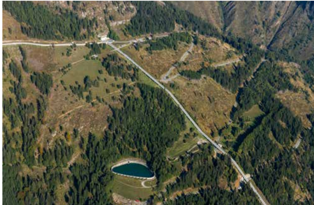
Speicher Gondelwiese mit der Druckrohrleitung Malta-Hauptstufe
