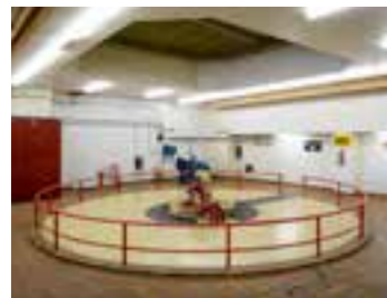
Kraftwerk Paternion, Maschinenhalle
