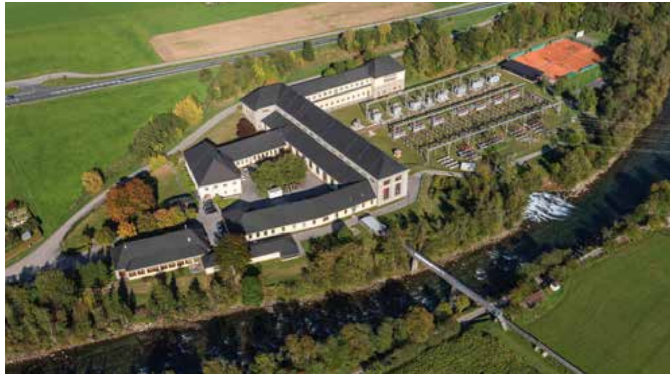
Kraftstation Kolbnitz mit Freiluftschaltanlage
