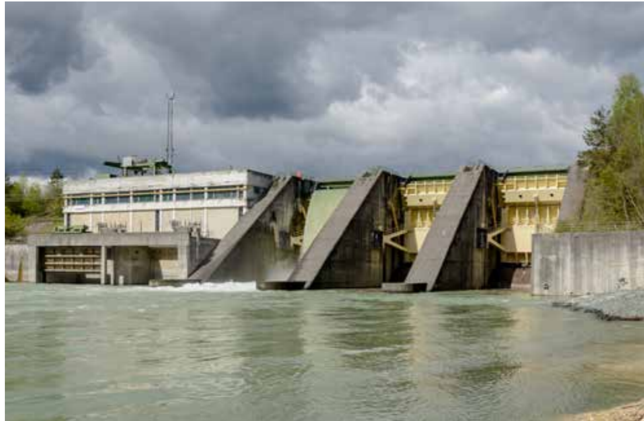
Kraftwerk Ferlach-Maria Rain
