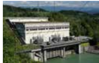
Kraftwerk Rosegg-St. Jakob, Kraftstation
