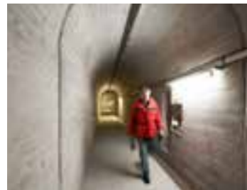
Kontrollgang im Sperrenkörper
