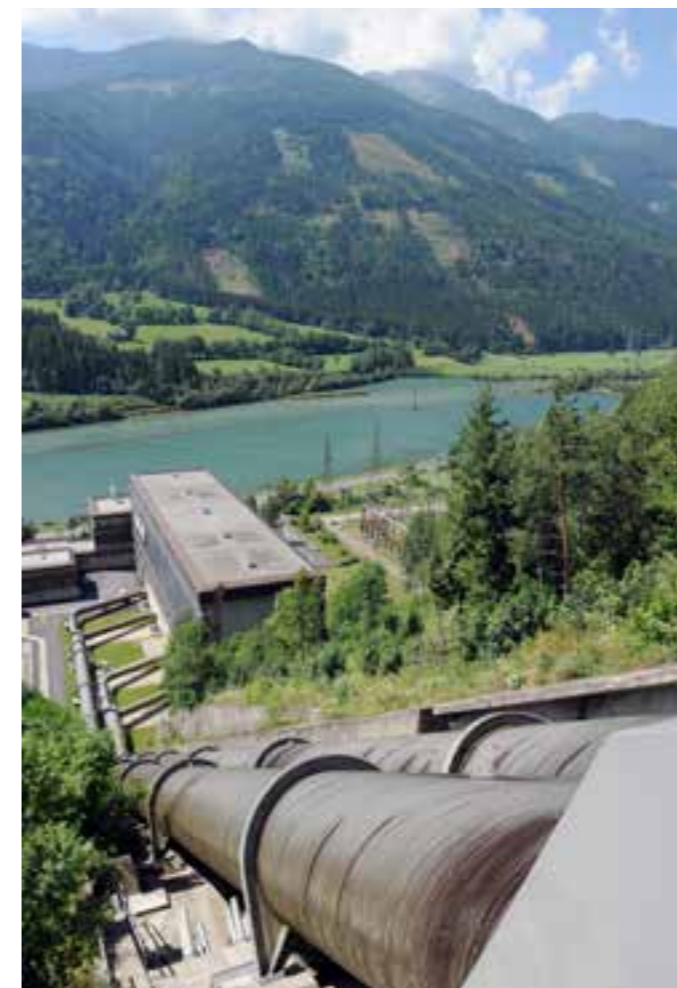
Kraftstation Rottau, Druckrohrleitung, im Hintergrund der Ausgleichsspeicher Rottau
