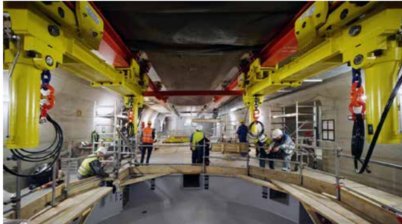
Pumpspeicherkraftwerk Reifseck II, Bauphase 2013
