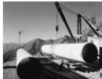
Montage der Druckrohrleitung der Speicherstufe Reibseck, 16.10.1954
