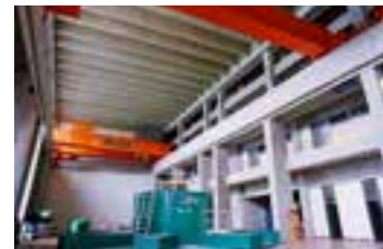
Kraftwerk Annabrücke, Maschinenhalle
