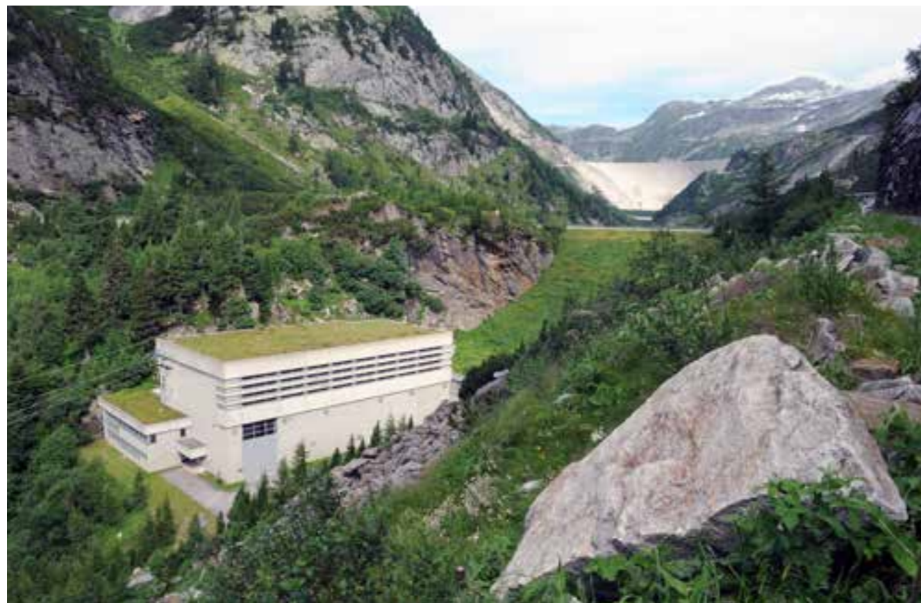
Kraftstation Galgenbichl, im Hintergrund die 200 m hohe Kölnbreinsperre
