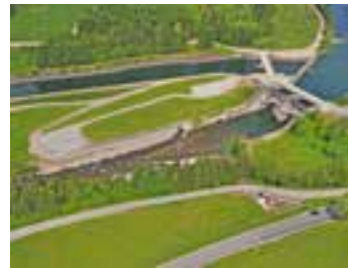
Wehranlage mit Fischwanderhilfe Rottau
