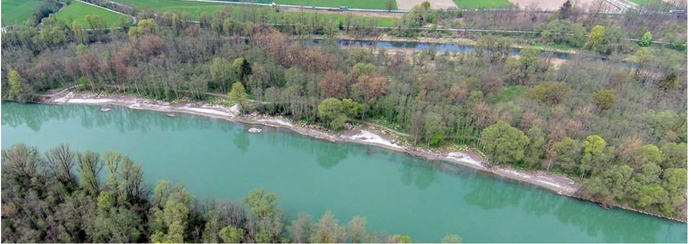
Uferrückbau mit „Strömungslenkern“; während des Hochwassers 2013 wurde die Aue 2 m überströmt.
