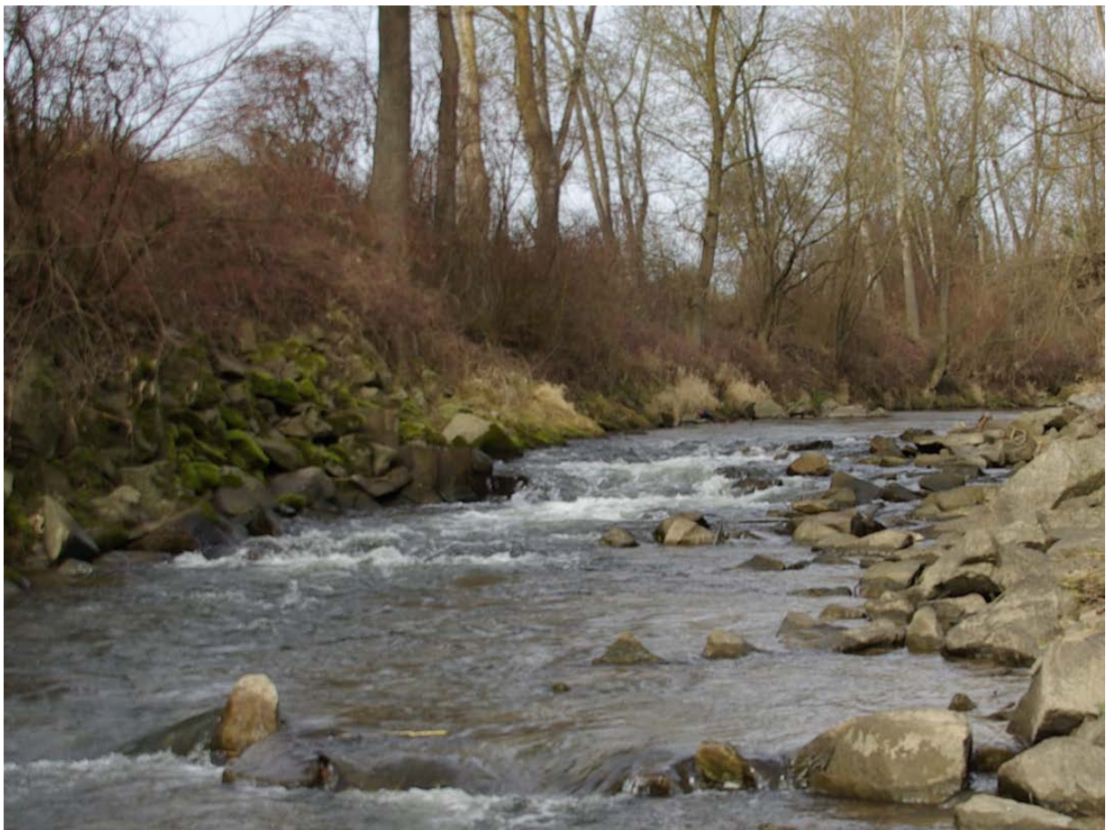
Rampe bei der Mündung der Großen Rodl
