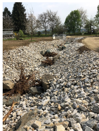
Abschnitt 2 KW Trattenmühle
