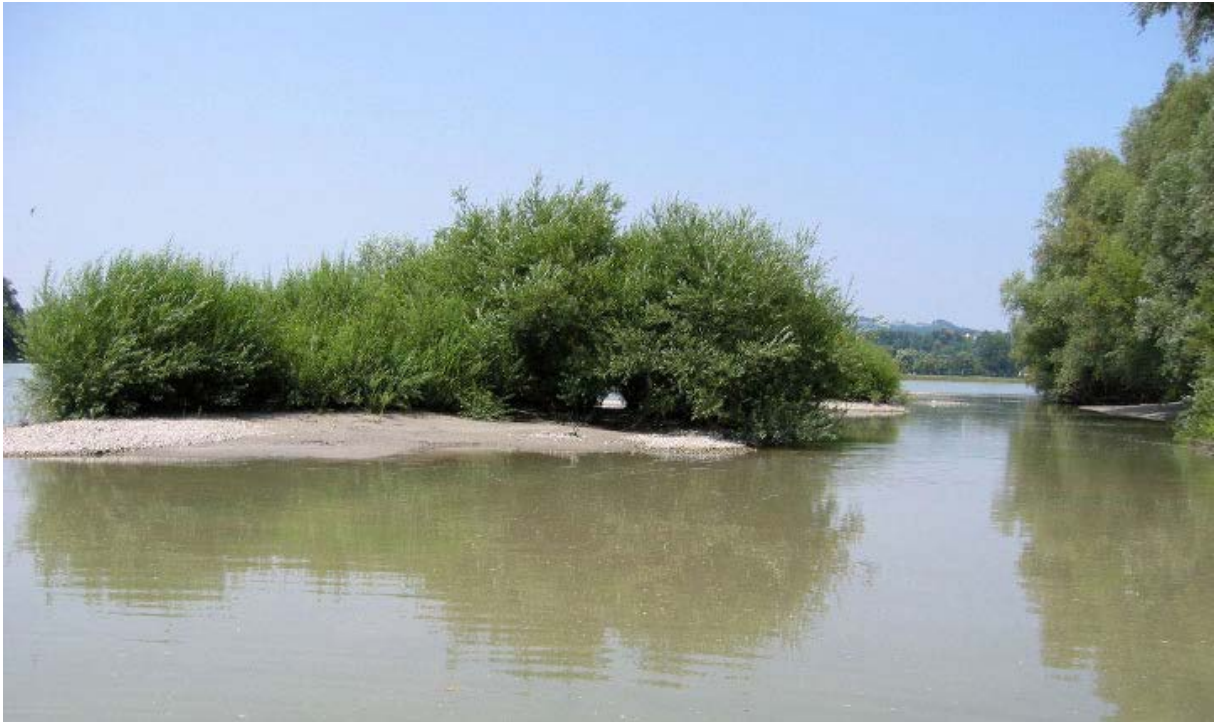
bereits fertiggestellte Kies- und Schotterinseln bei der Ybbser Scheibe
