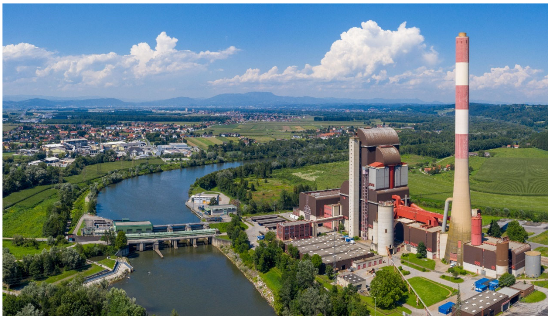
Abb. 5: Luftaufnahme des FHKW Mellach
