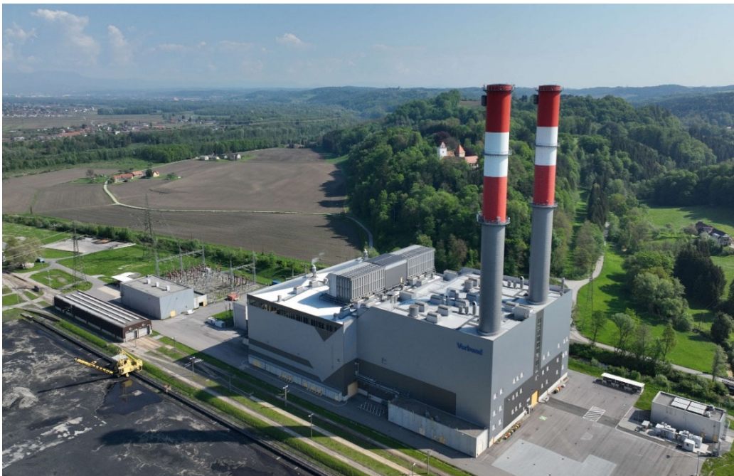
Abb. 7: Luftaufnahme des GDK Mellach
