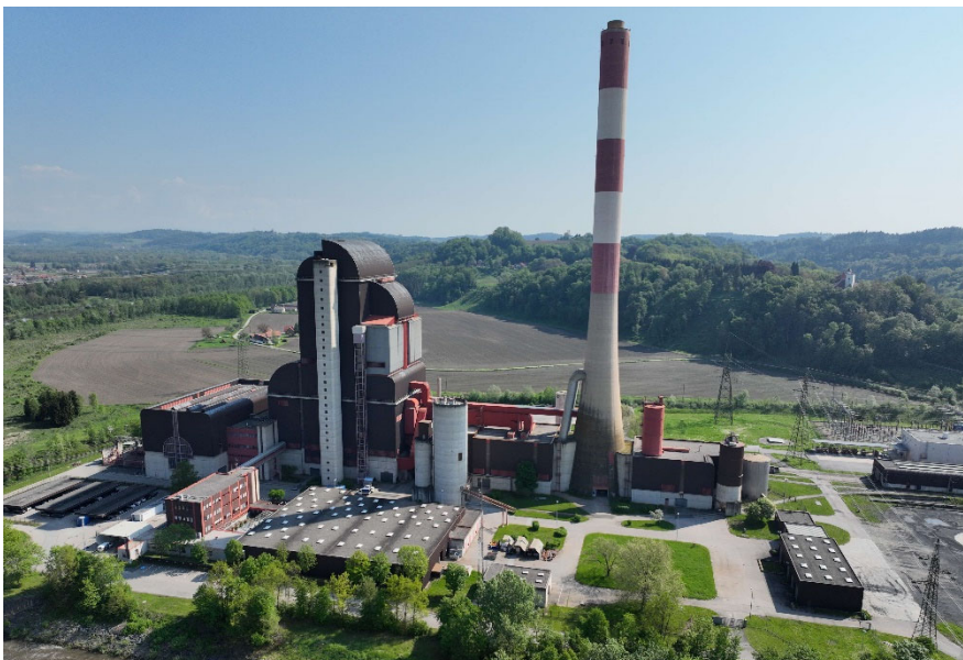
Abb. 4: Ansicht des FHKW Mellach
