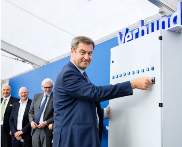
Feierliche Inbetriebnahme: Gemeinsam mit dem VERBUND-Vorstand (links) eröffnete der bayerische Ministerpräsident Markus Söder das erweiterte Kraftwerk Jettenbach-Töging.
