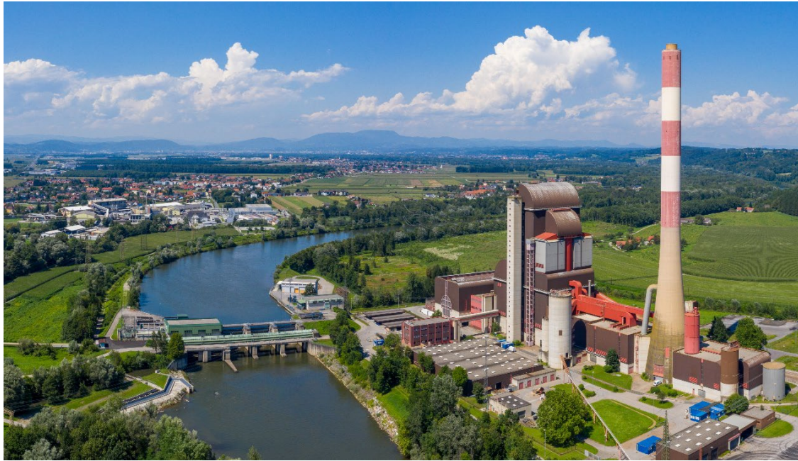
Luftaufnahme des FHKW Mellach
