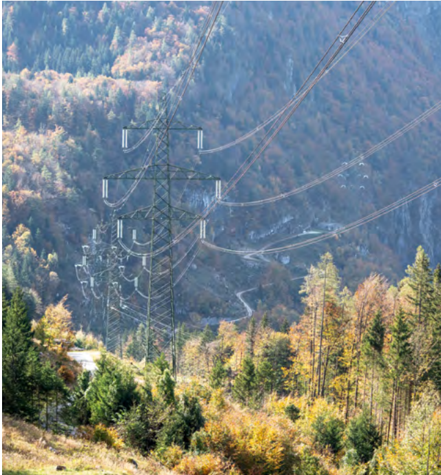
Die neue 380-kV-Salzburgleitung umfasst 449 Masten und eine Leitungslänge von 128 Kilometern.
