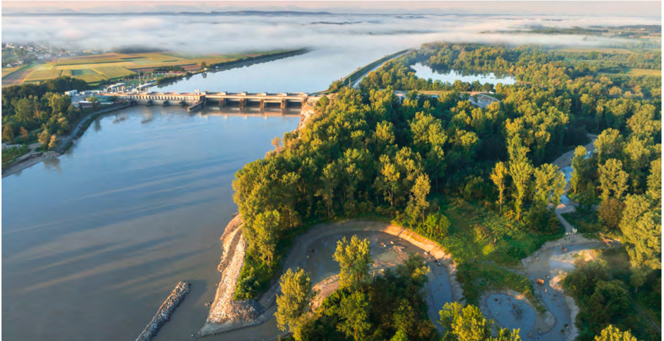
Blick vom Unterwasser auf das Innkraftwerk Braunau-Simbach
