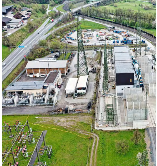
Im Zuge des Projekts 380-kV-Salzburgleitung wurde auch das Umspannwerk Pongau neu errichtet.
