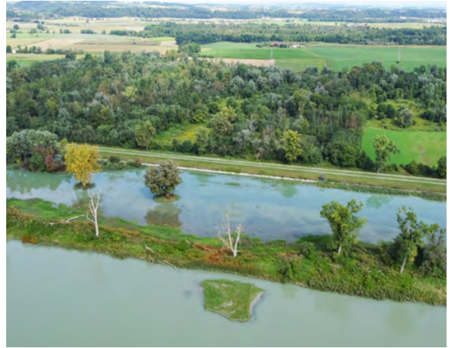
Die Luftaufnahme zeigt den westlichen Teil der Aufhausener Lacke mit Wasserflächen und Ufervegetation im September 2025 (sechs Monate nach Fertigstellung).
