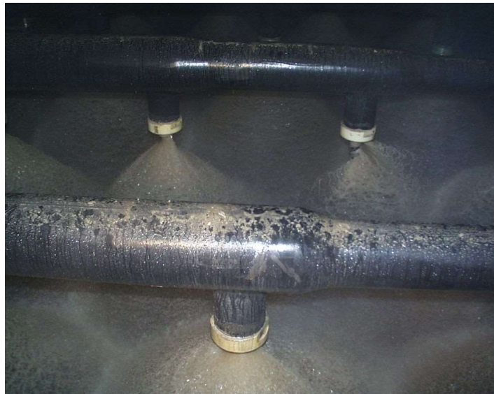
Abbildung 3: Sprühdüsen in der REA
